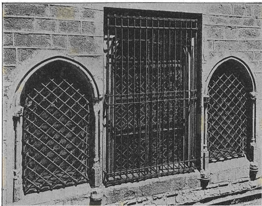
Ventanales de la Capilla Muzárabe, en el costado del Mediodía
