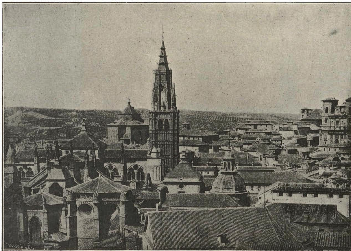
Conjunto general de cubiertas por la parte oriental, y fachada E. de la Torre
