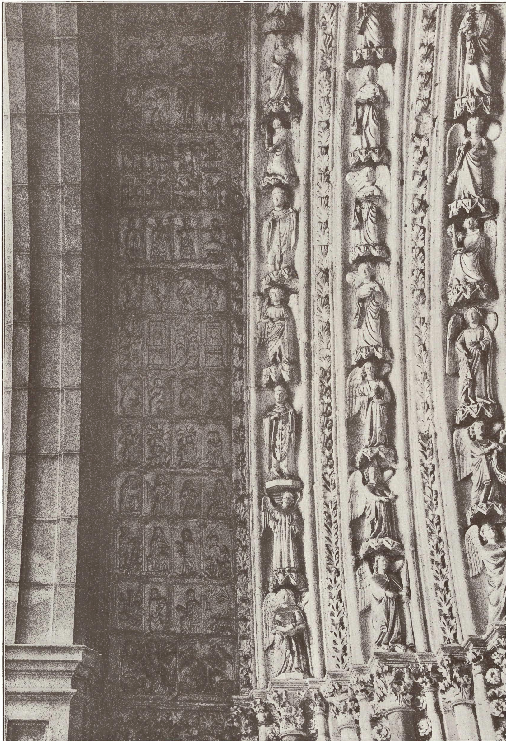
Detalle de las archivoltas y de los relieves historiados de la «Puerta de la Chapinería» en la Catedral (costado de la derecha de la Puerta)
