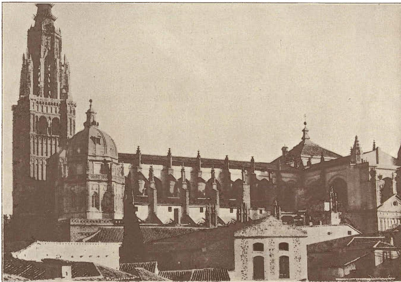
Perspectiva de las cubiertas por el costado del Mediodía, hasta el Crucero
