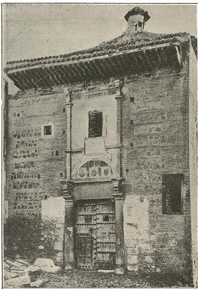
Fachada del llamado «Palacio del Rey don Pedro»
