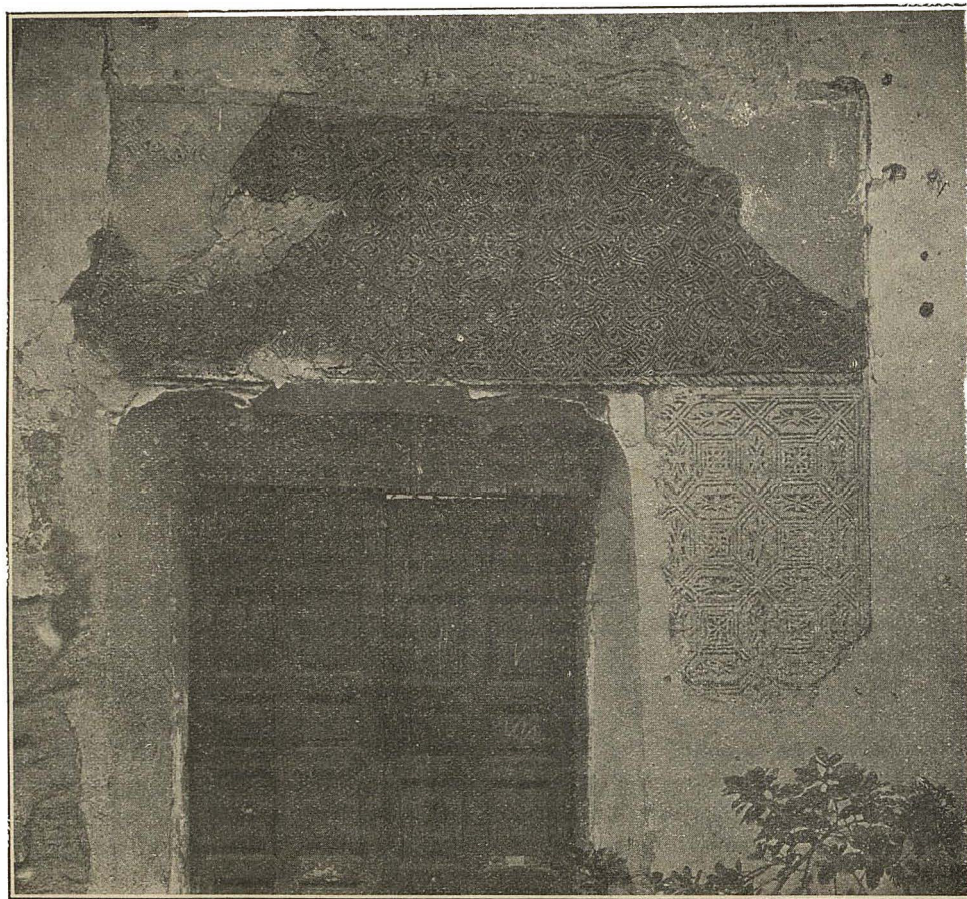
Restos de yesería en el patio
