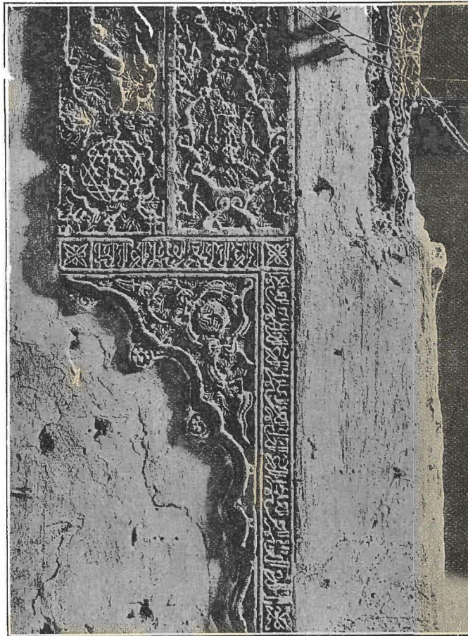
Aleta del arco del pabellón de la izquierda por el interior.
