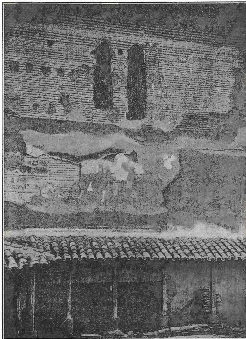
EL TRÁNSITO. — Fachada del Norte
