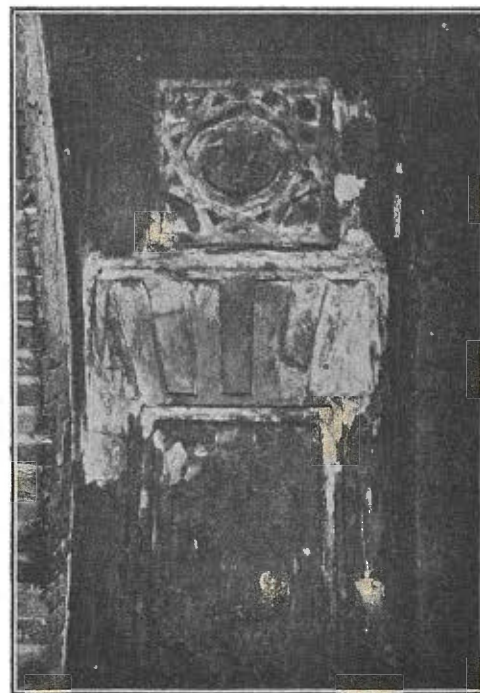
MEZQUITA DE LAS TORNERÍAS Pequeña fenestra adovelada y celosía de la cúpula central interior Petite fenètre douellée et jalousie de la coupole centrale intérieure
