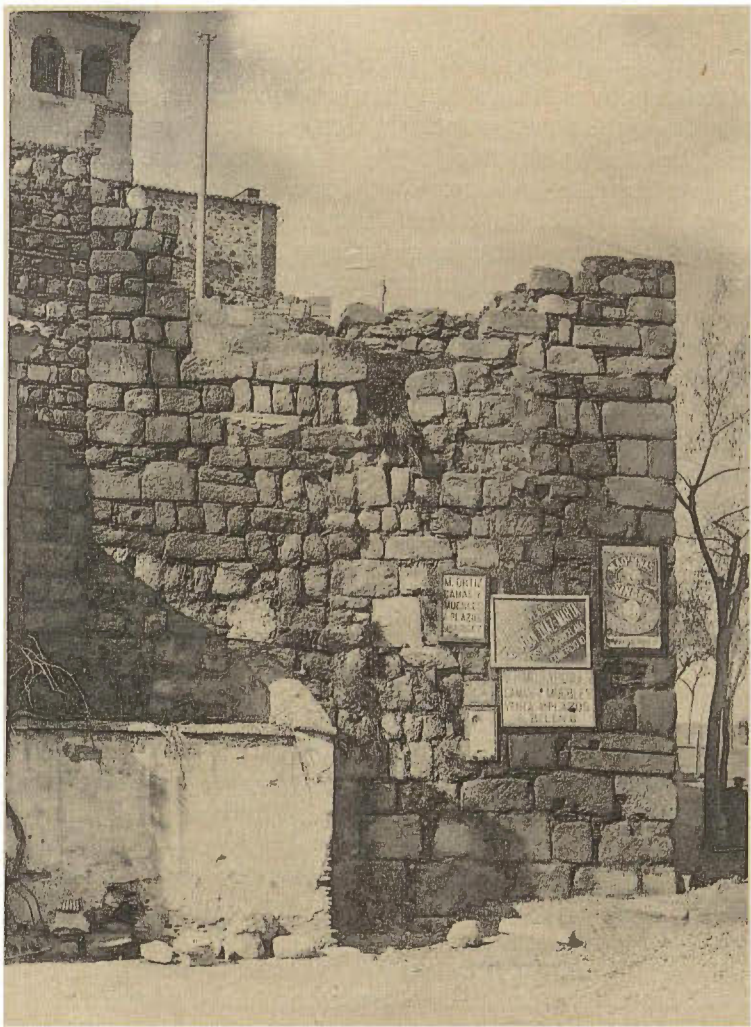
Restos de construcción romana en el Torreón de la Plaza de Armas del Puente de Aloántara
