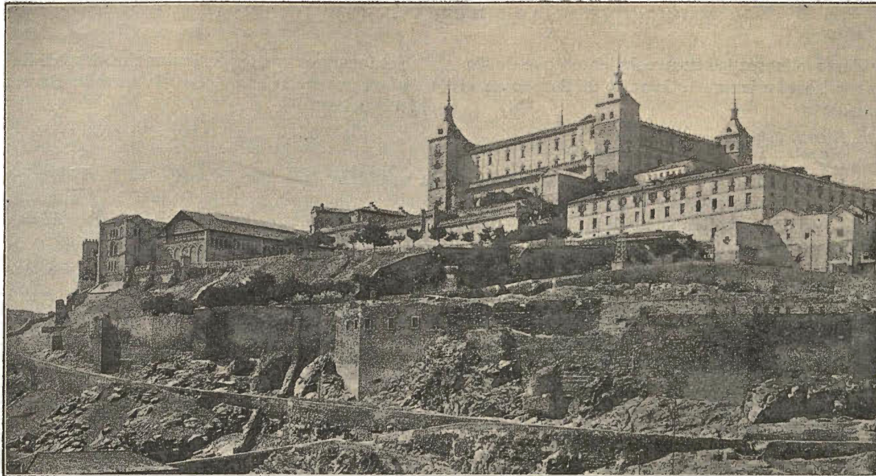
Restos del recinto del "Al-Hizém", desde la Puerta de los Doce Cantos hasta la "Plaza de Armas" del Puente de Alcántara Restes de l'enceinte de l' "Al-Hizém", depuis la Porte de los Doce Cantos jusqu'à la "Place d'Armes" du Pont d'Alcántara
