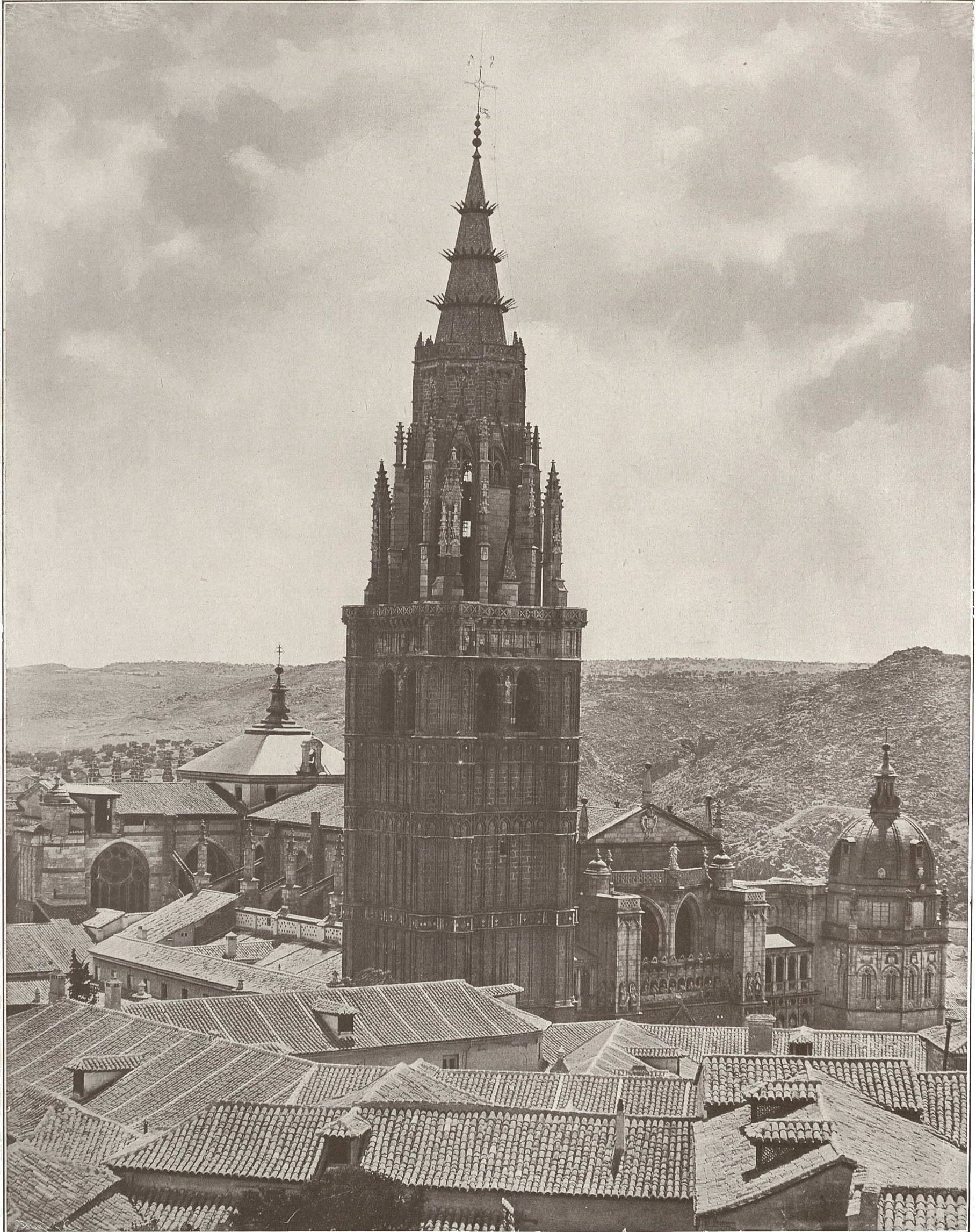
Catedral - La Torre - Perspectiva de las cubiertas del costado Septentrional
