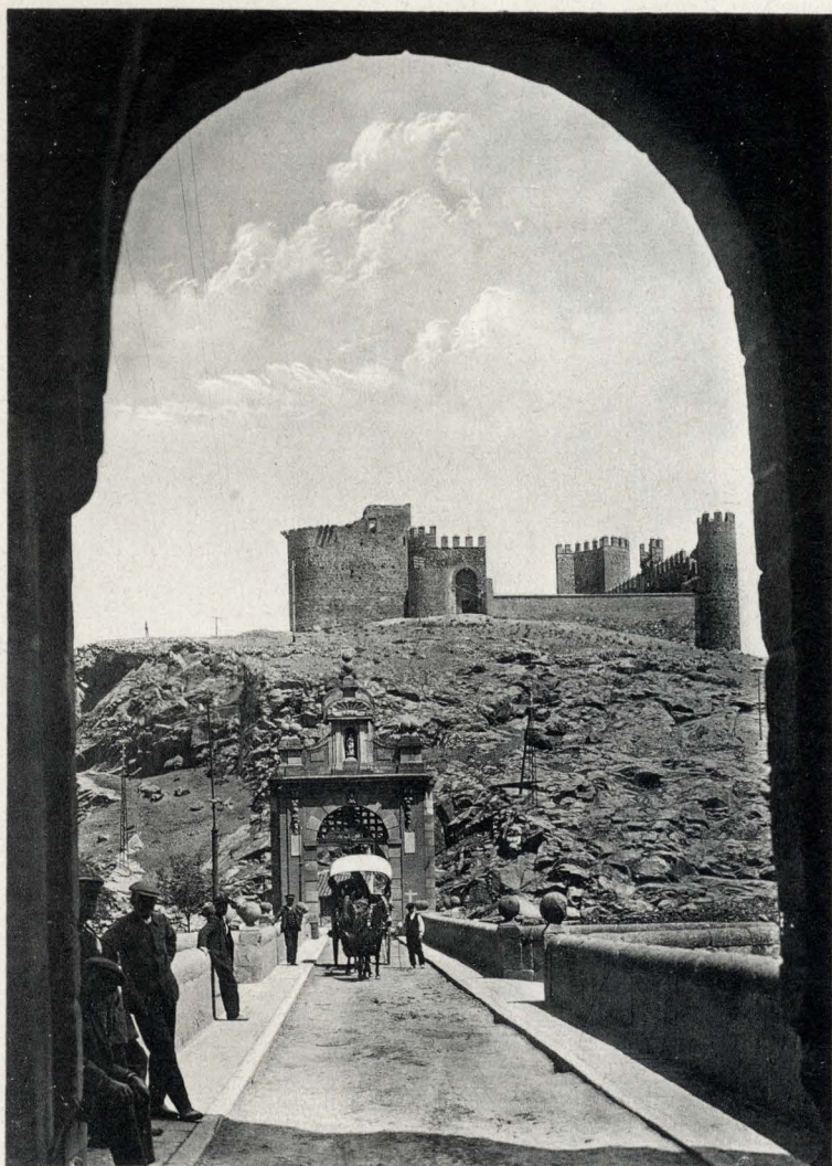
Puente de Alcántara y Castillo de San Serbando.
