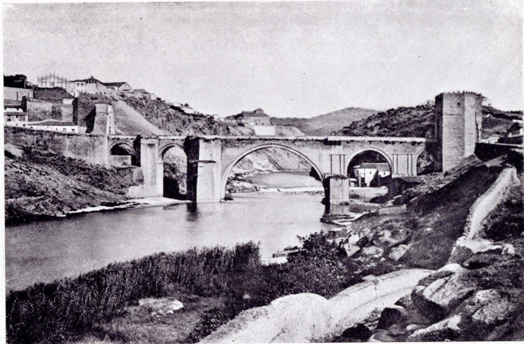
Sustituyó al que fué destruído por el Tajo en 1203 y restaurado en 1640 y 1780. Tiene cinco arcos flanqueados en ambos extremos por fuertes torreones almenados.
