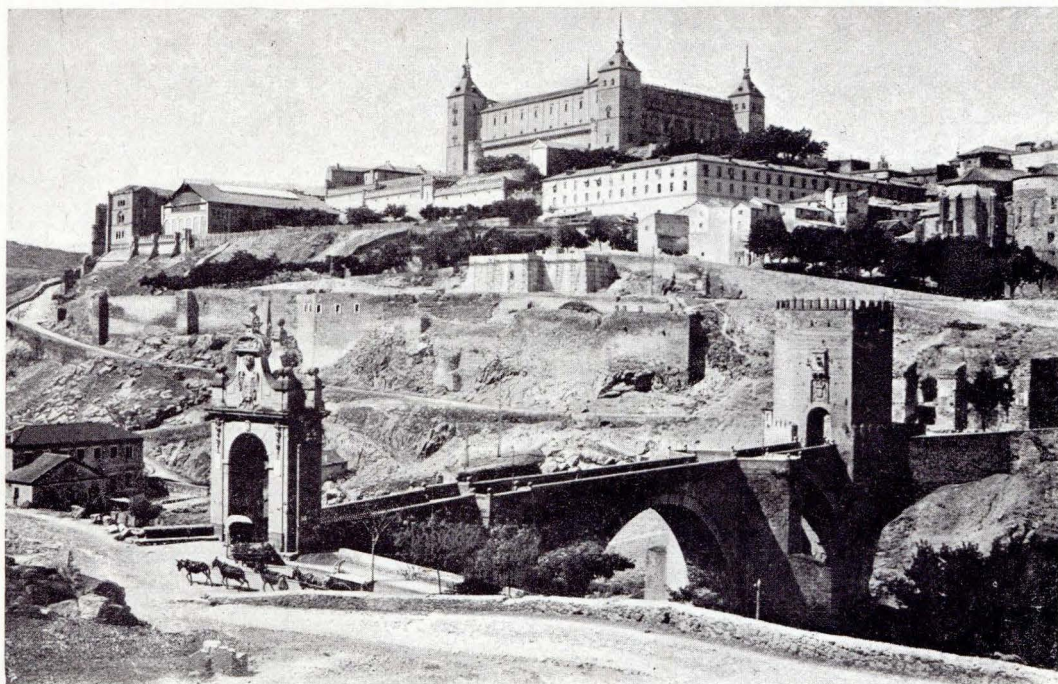
Data del siglo XIII, con posteriores restauraciones. La entrada conserva un torreón almenado, habiéndose sustituido el de salida por un arco á principios del siglo XVIII.
