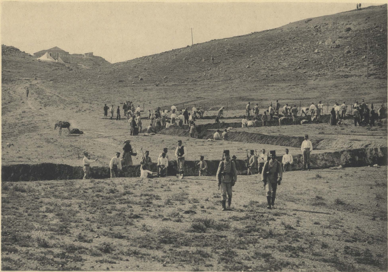
TRABAJOS DE APROCHE
