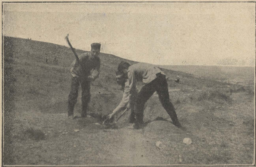
Construcción de un pozo de titador.
