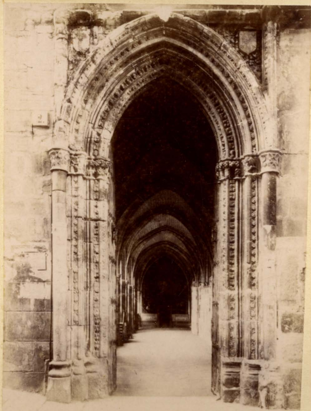
CATEDRAL DE TORO — b. — Puerta de Nino Perdido.
