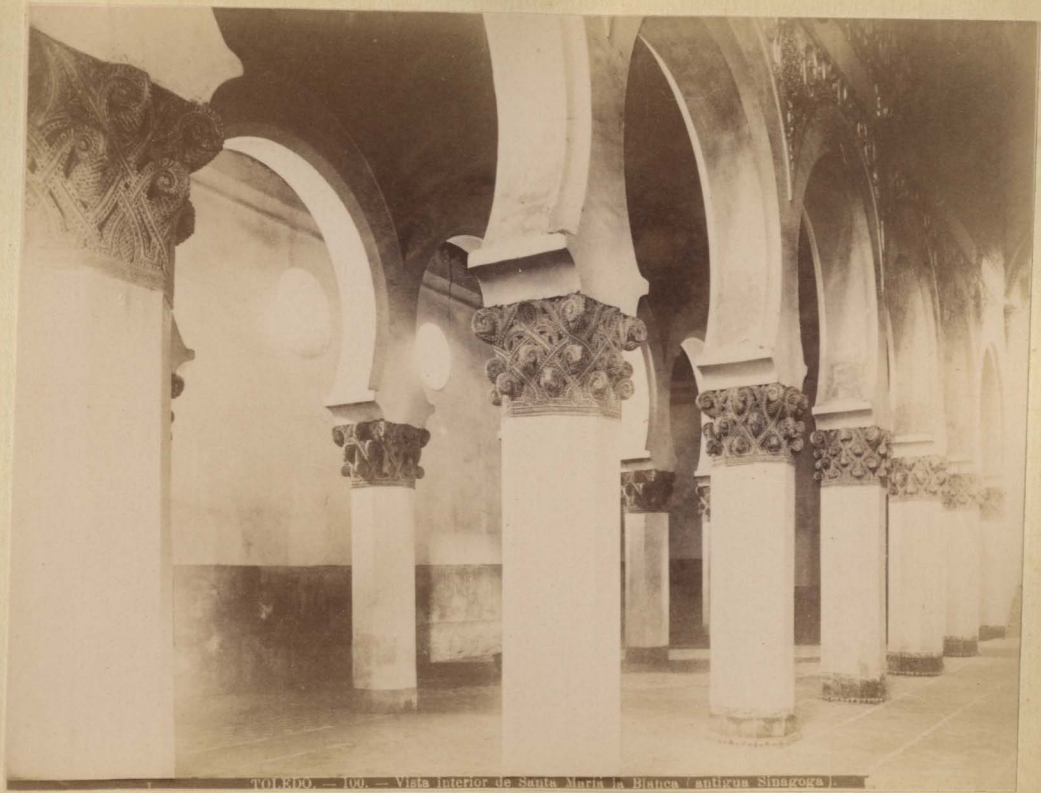
TOLEDO. — 109. — Vista interior de Santa María la Blanca (antigua Sinagoga).
