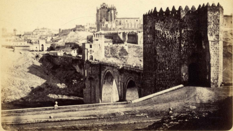
VISTA TOMADA DESDE EL PUENTE DE SAN MARTIN.
