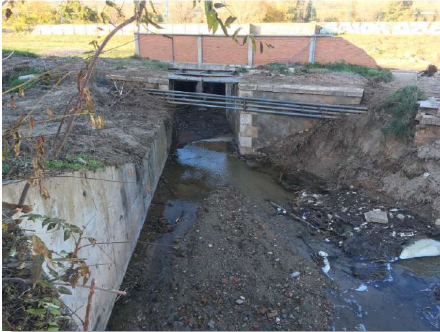
Vista del cauce artificial y paso existente fuera del ámbito aguas arriba de la UA-100 Oeste
