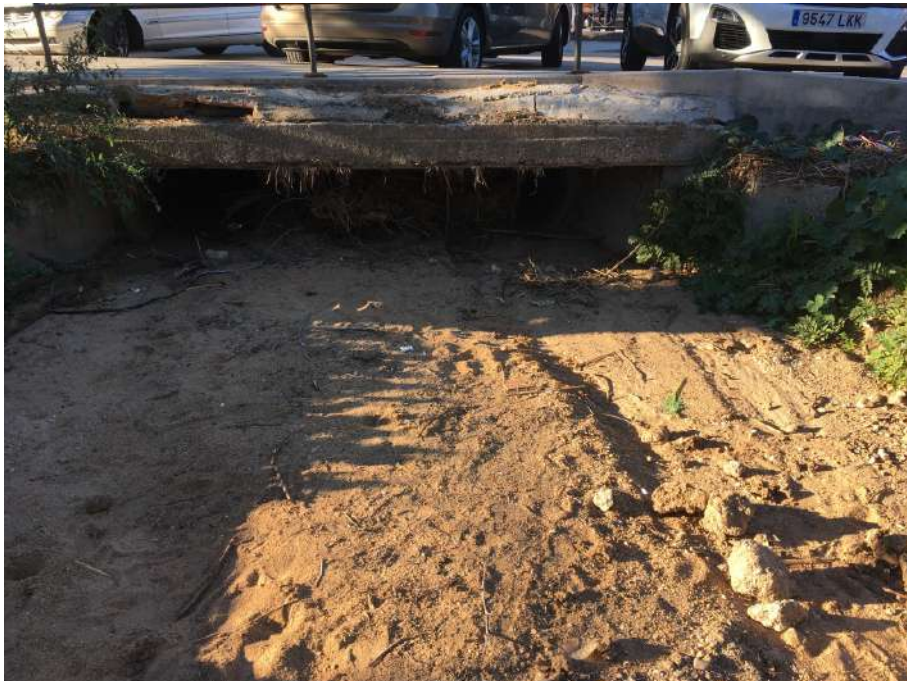
Inicio del tramo entubado bajo las calzadas con 3 tubos de diámetro 1 m, a 500 m aguas arriba de la UA-100 Oeste
