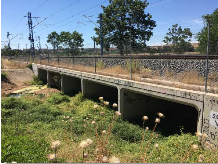
Obra de paso bajo la vía del ferrocarril Madrid –Toledo, sobredimensionado con una batería de 5 cajones de 4 \times 2 \text{m}^2 , aguas abajo fuera del ámbito de la UA-100 Oeste
