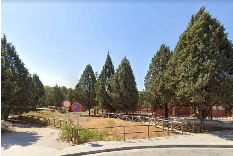
Vista del cauce natural e inicio del tramo entubado bajo las calzadas, a 500 m aguas arriba de la UA-100 Oeste
